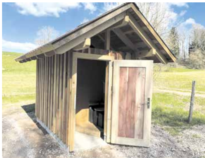
Gute Nachrichten für alle Naturfreunde: Neues Toilettenhäuschen am Grillplatz Fuchslochhütte in Haueneberstein
