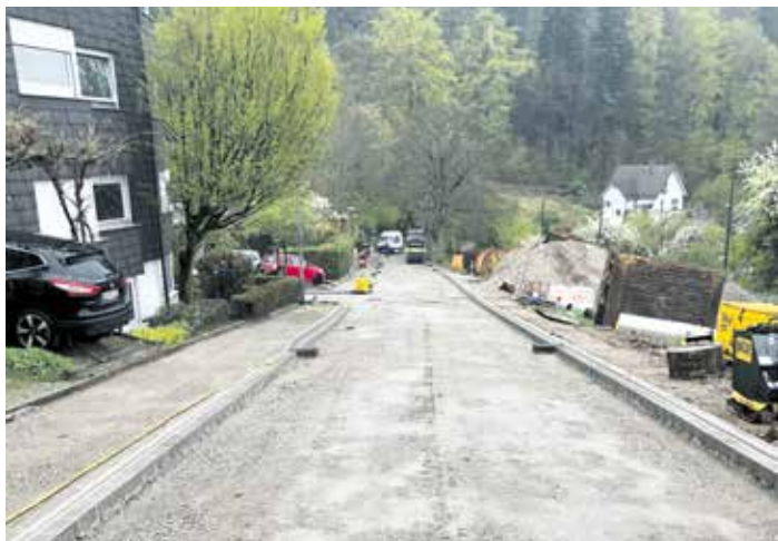
Der Abschluss der Arbeiten in der Hilsbrunnenstraße steht kurz bevor.
