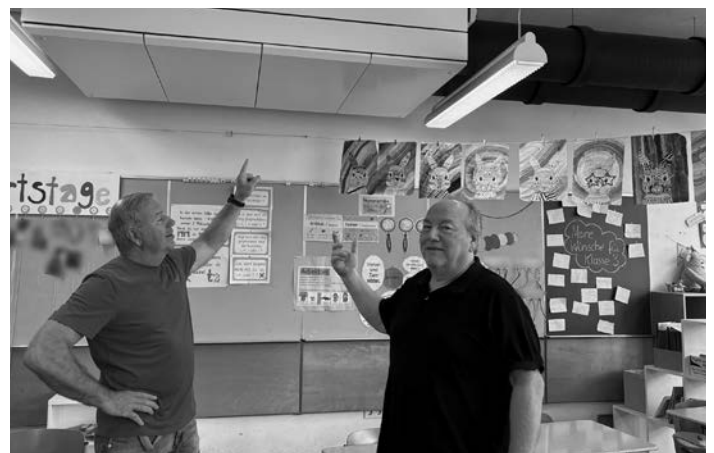
Projekt abgeschlossen: Ralf Weiler (links), Hausmeister der Gustav-Heinemann-Schule, und Jürgen Namyslo, Projektleiter vom städtischen Hochbau, freuen sich über die neue Raumlufthechnischen Anlagen in der Gemeinschaftsschule. Foto: Stadt Rastatt/Isabelle Joyon
