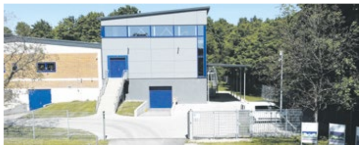
Das Wasserwerk Ottersdorf im Naturschutzgebiet Rastatter Ried ist ein wichtiger Baustein der Rastatter Trinkwasserversorgung. Foto: Stadtwerke
