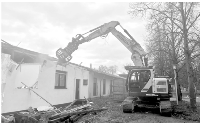
Die Abbrucharbeiten haben begonnen
