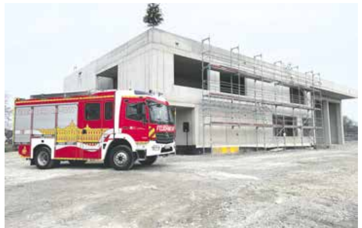
Das Grundgerüst steht, nun kann der Innenausbau beginnen: In Plittersdorf wurde Richtfest der neuen Feuerwache gefeiert.
