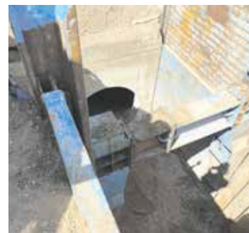
Die Kanäle der bereits errichteten Schächte werden aktuell verbunden.
