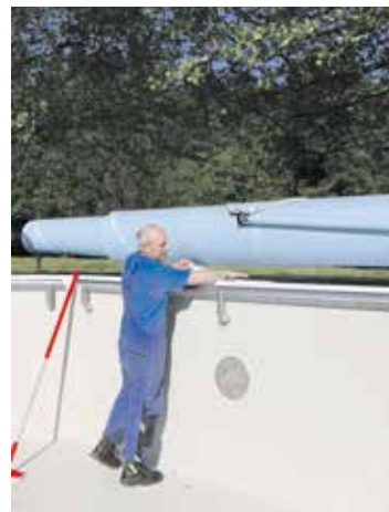
Letzte Arbeiten am Außenbecken.
