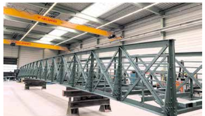
Aufwendig wird derzeit der rund 130 Jahre alte Schachtelbachsteg in einer Werkstatt eines spezialisierten Stahl- und Metallbauunternehmens saniert.
